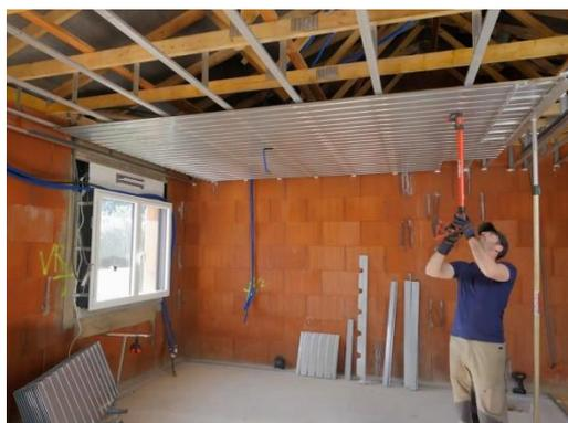
**Aspects particuliers traités :** les 2 maisons laboratoires ont été équipées d'un plafond hydraulique Innovert pour tester sa capacité de rafraîchissement. Les performances de rafraîchissement du plafond ont été comparées à celles du plancher rafraîchissant puis à celles de la climatisation par PAC air-air multi-splits.
